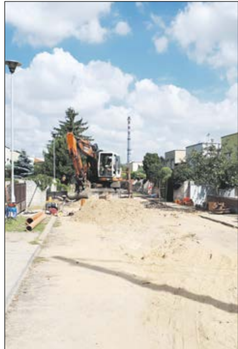
Na ul. Cybulskiego w Lesznie trwa przebudowa kanalizacji sanitarnej.
