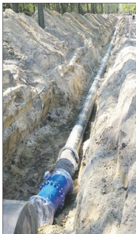
Przebudowa rurociągu wody surowej do Stacji Uzdatniania Wody w Strzyżewicach.
