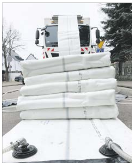
Przebudowa sieci kanalizacji ogólnospławnej w technologii bezwykopowej w ul. Andrzejewskiego w Lesznie.
