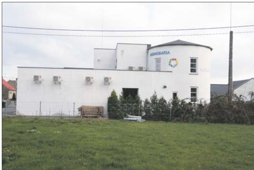
Zdziwienie wielu osób budzi charakterystyczny, okrągły budynek normobarii w Bojanowie (po prawej stronie) Tam właśnie panuje ciśnienie około 1500 hPa.
