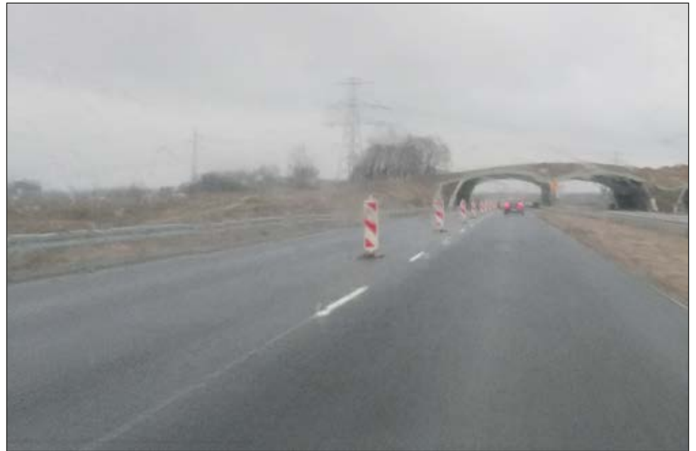
Podpoznański odcinek drogi S5 w budowie.
