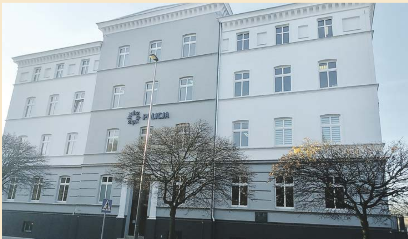
Remont elewacji oraz dachu Komendy Miejskiej Policji w Lesznie.
