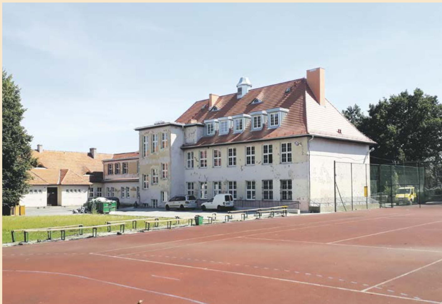
Remont dachu w Zespole Szkół numer 1 w Trzebnicy.
