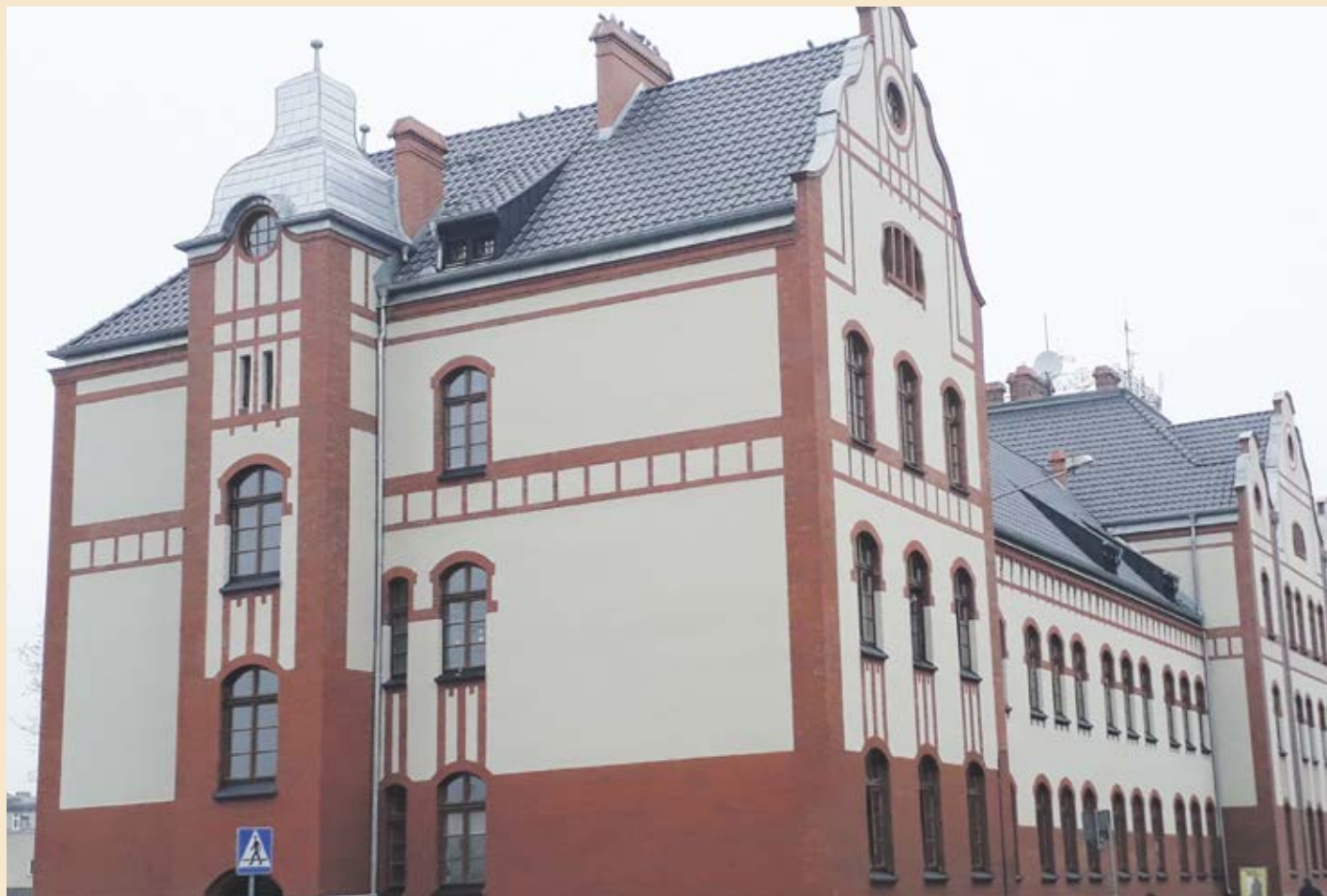
Słynny Koszarowiec przy ul. Dąbrowskiego w Lesznie po kompleksowej naprawie dachu w wykonaniu PHB Tyliński.
