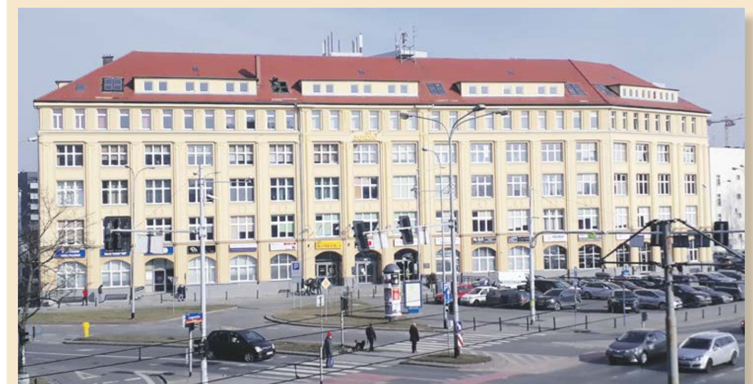
Kompleksowa modernizacja budynku biurowego, położonego przy pl. Solidarności we Wrocławiu.
