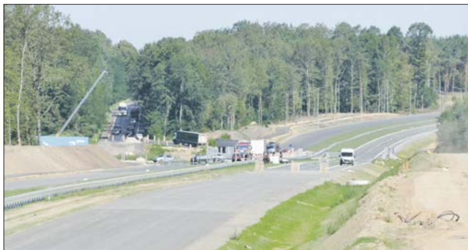
Budowa drogi pomiędzy Radomickiem a Śmigłem - stan na koniec lipca.
