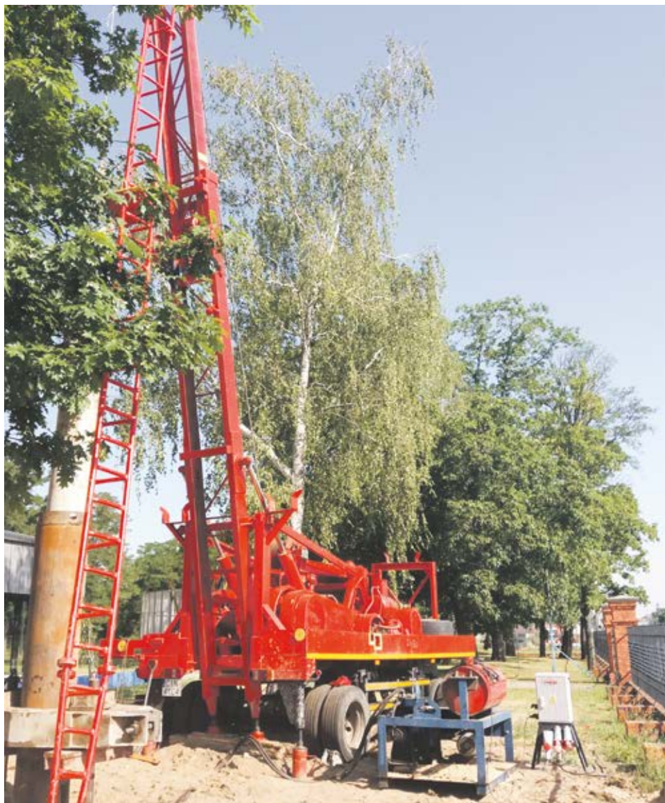
SUW Zaborowo - wykonanie otworu studziennego.
