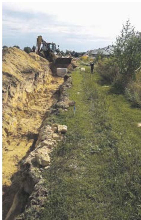
Budowa sieci kanalizacyjnej.
