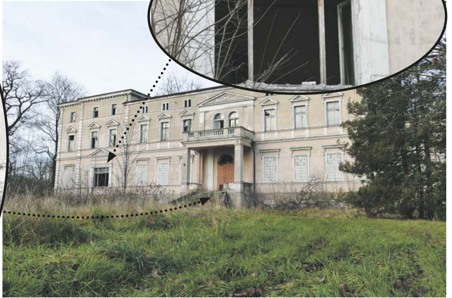
Pałac w Kawczu z zewnątrz jest w stanie agonalnym.
