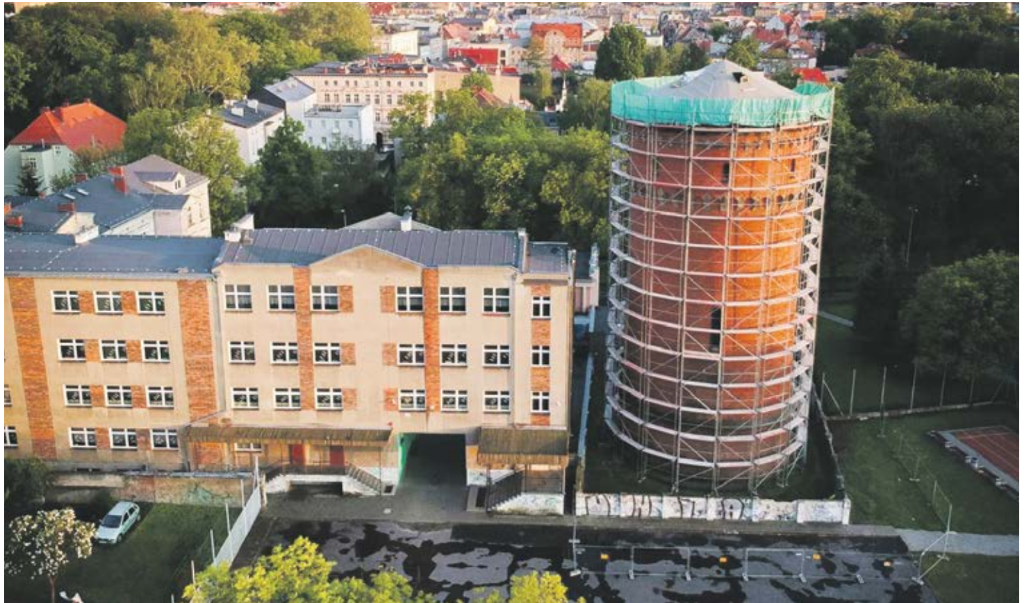
Modernizacja dachu wieży ciśnień przy ulicy Poniatowskiego w Lesznie.
