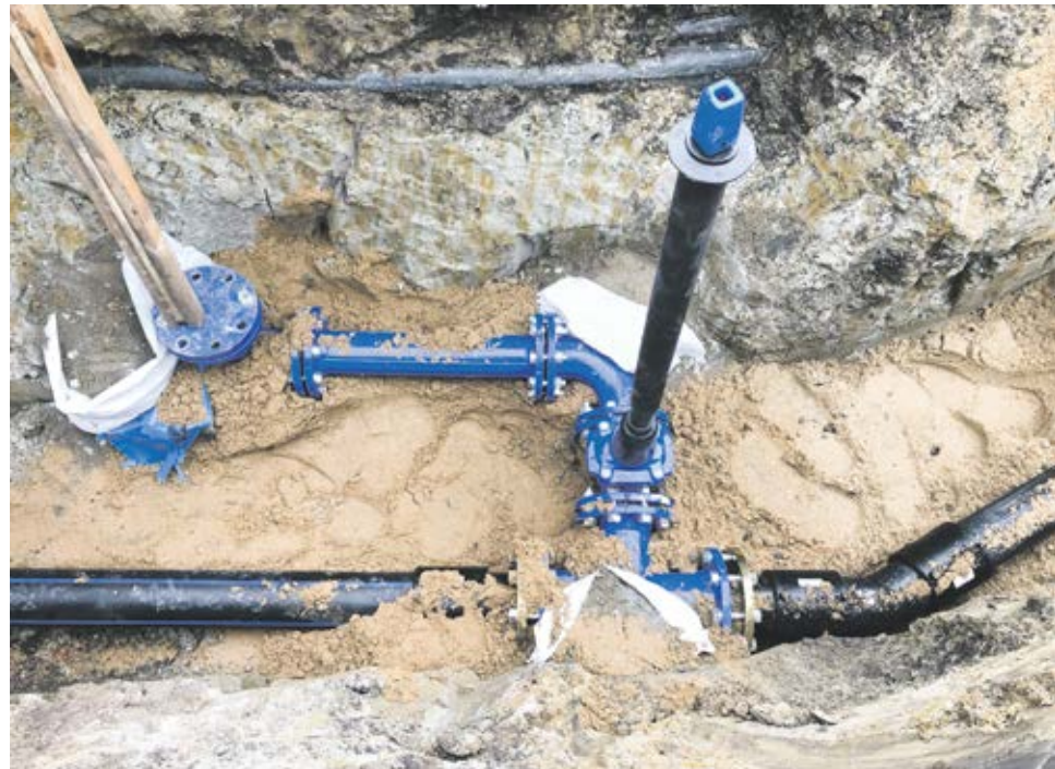
Budowa sieci wodociągowej.
