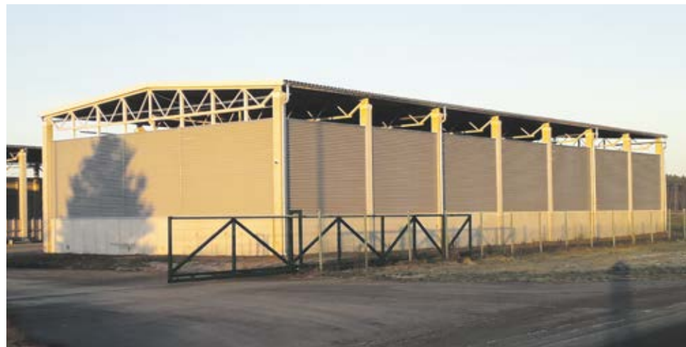
Oczyszczalnia ścieków w Henrykowie - montaż osłon przeciwwiatrowych.
