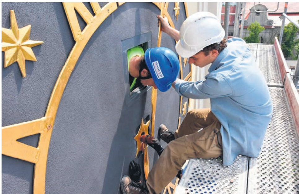
Fot. M. Urban, Miejski Konserwator Zabytków / leszno.pl Montaż zewnętrznych elementów ratuszowego zegara.
