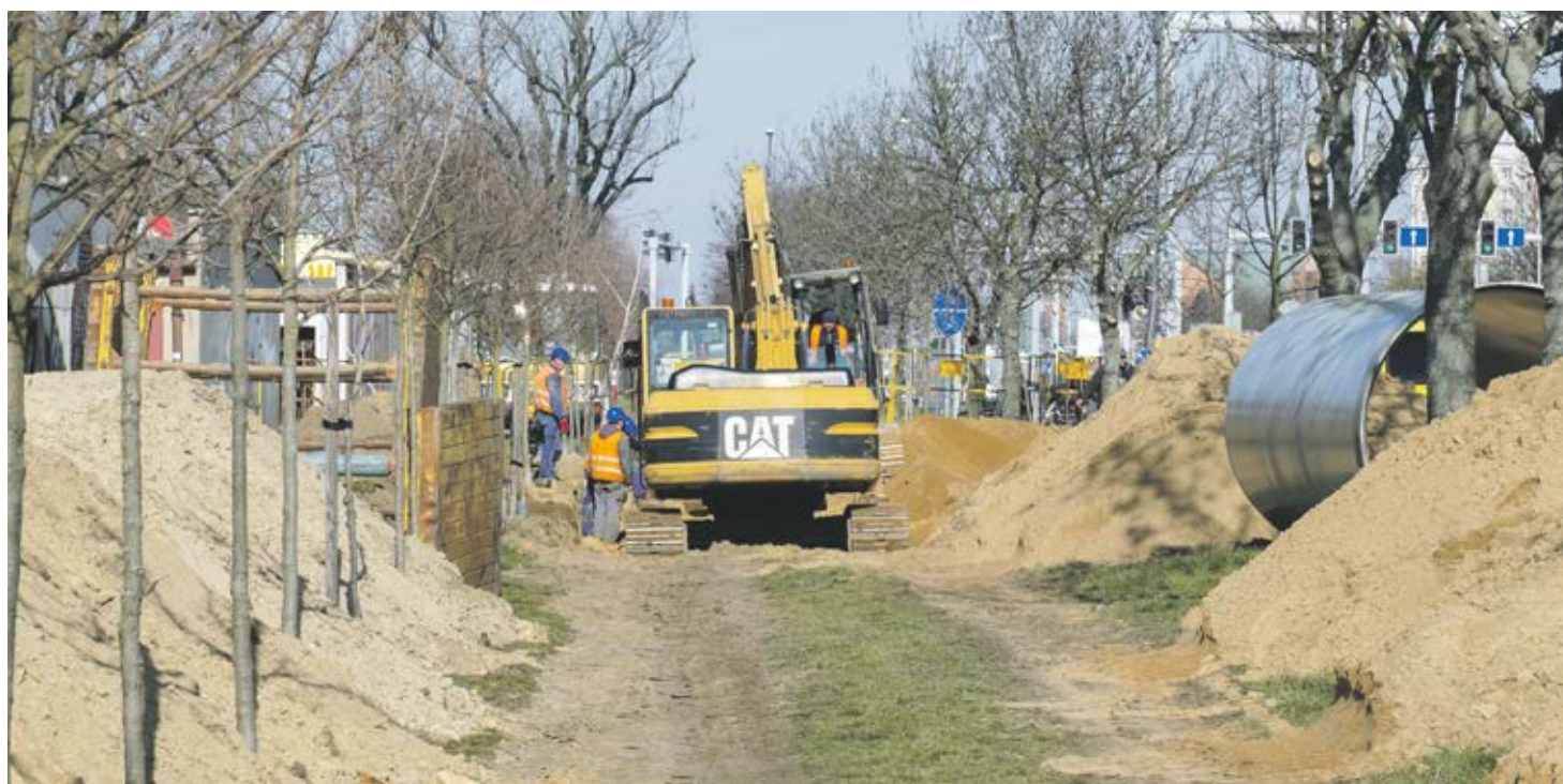
Budowa kolektora trwa na długim odcinku. Tutaj prace przy skrzyżowaniu Alei Konstytucji 3 Maja i ulicy 55 Pułku Piechoty.
