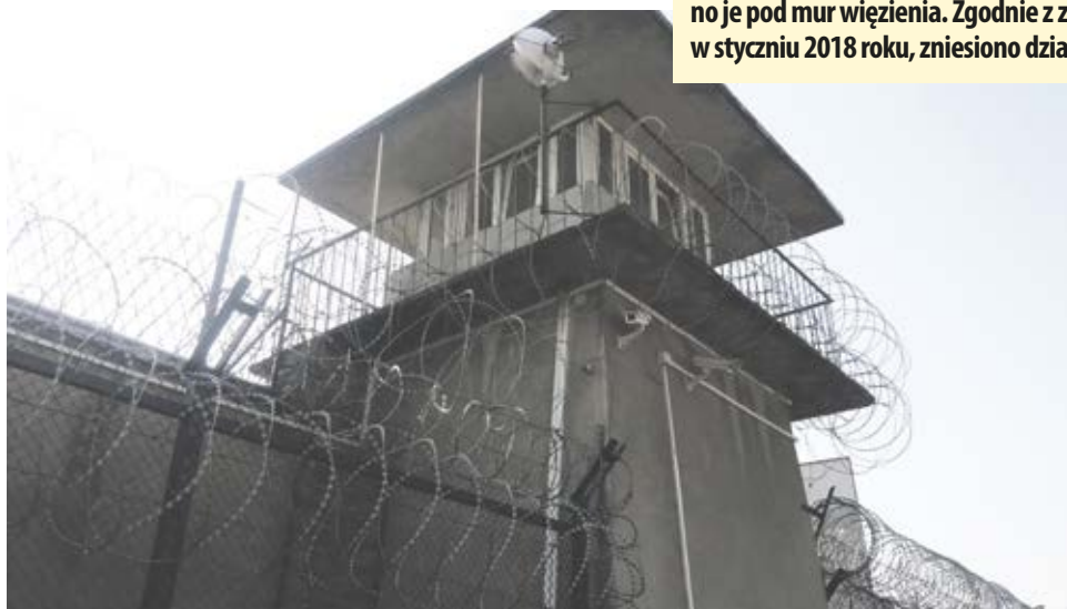
Widok na wieżę wartowniczą.
