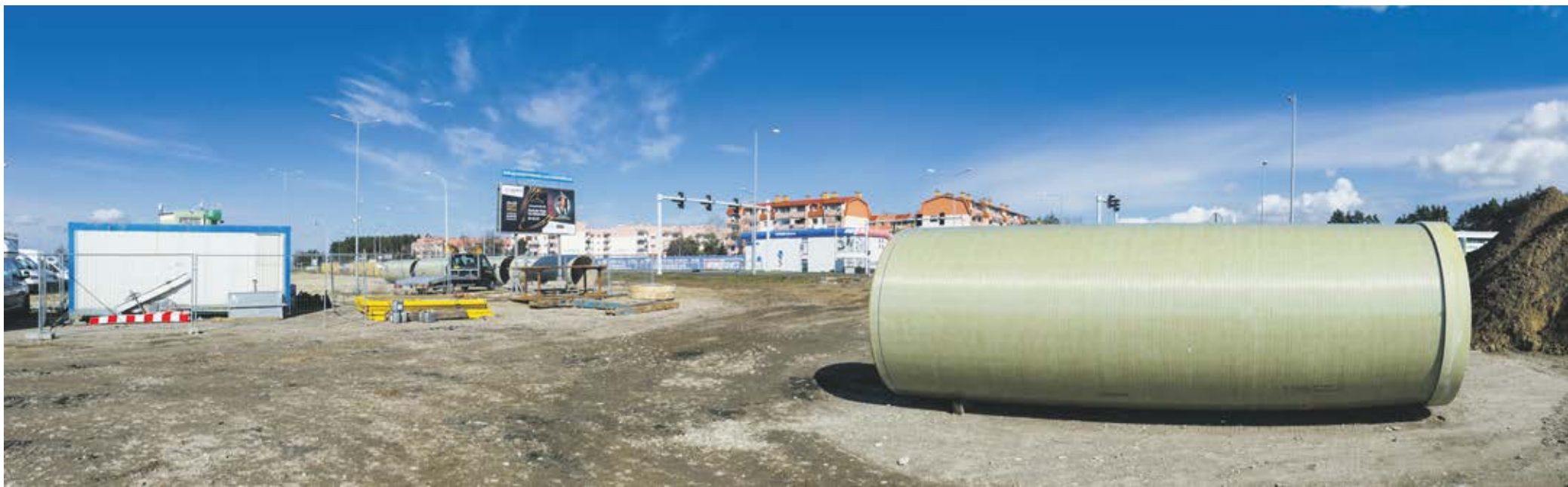
Budowa kolektora wschodniego to duże przedsięwzięcie. Na pustym placu przy skrzyżowaniu Alei Konstytucji 3 Maja i ulicy Geodetów można zaobserwować potężne
