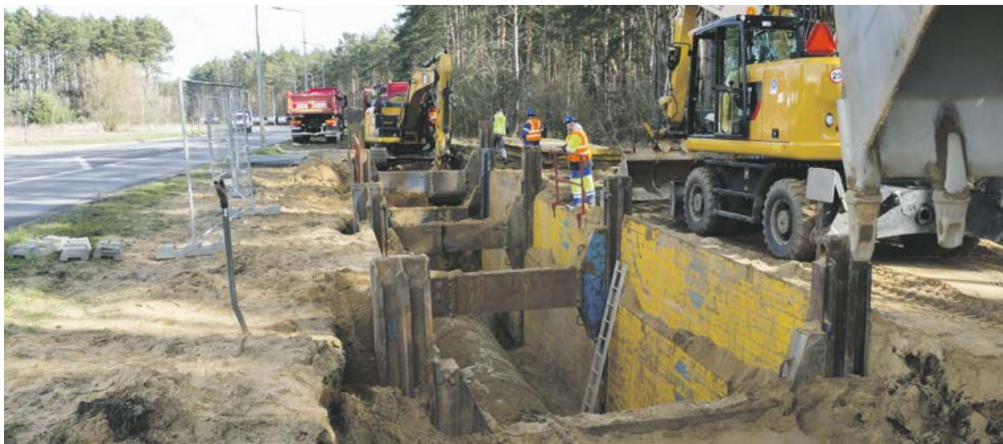
Prace przy kolektorze wschodnim prowadzone przy ulicy Geodetów, a więc niedaleko ujścia do zbiorników w strefie I.D.E.A.
