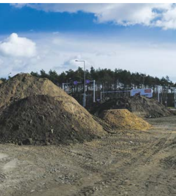
rury, które zostaną zakopane w ziemi.
