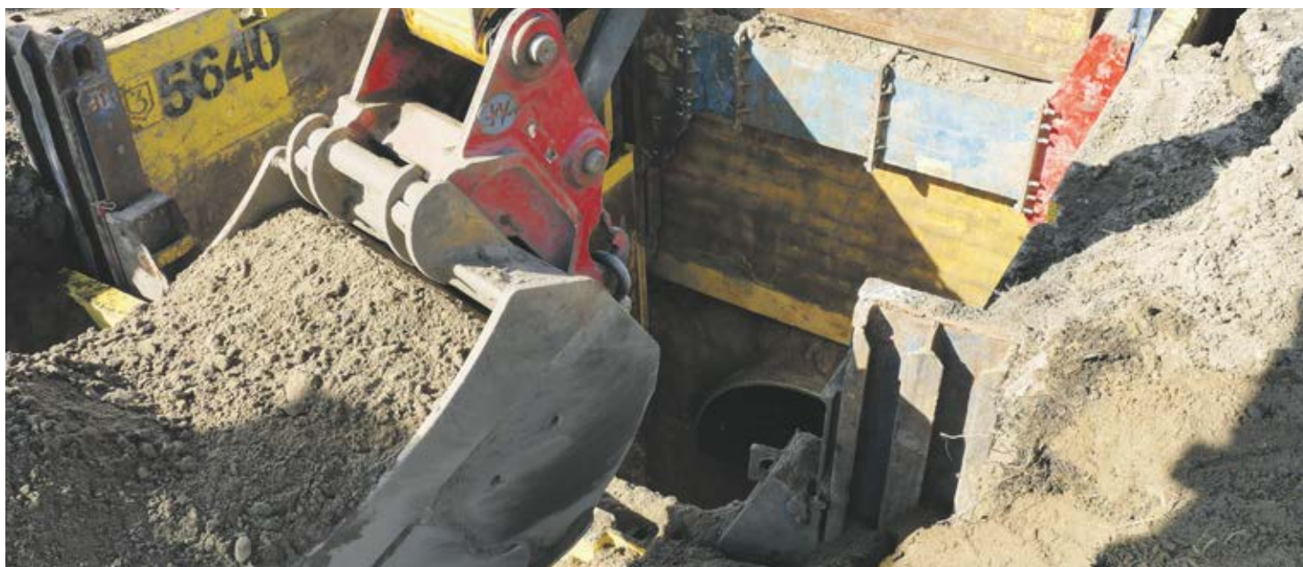
Prace przy budowie kolektora prowadzone są na głębokości od 2,5 do nawet 4,5 metrów.
