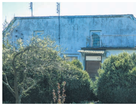
Budynek z 1934 r. ul. Sygietyńskiego.
