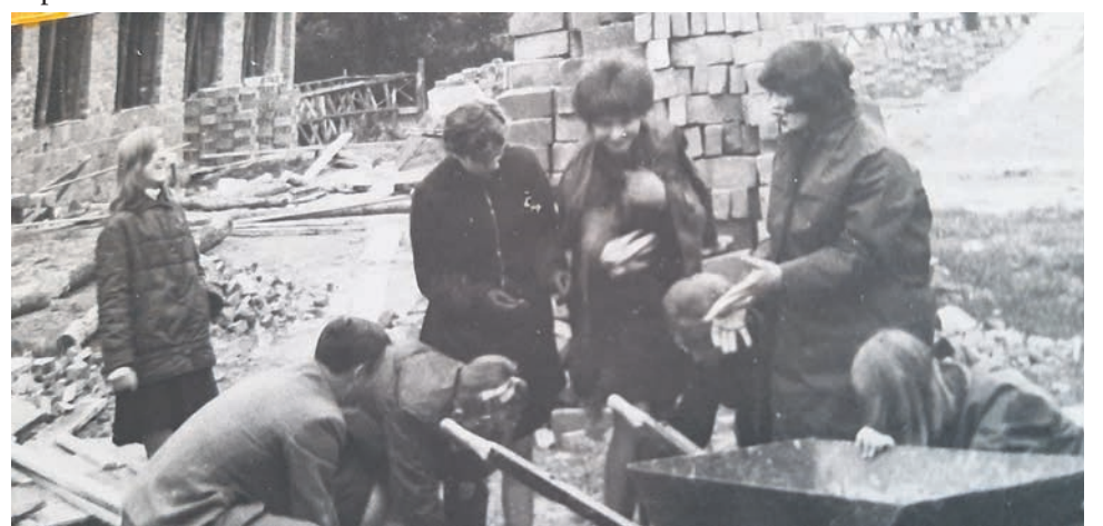
Prace społeczno-użyteczne przy budowie budynku.
