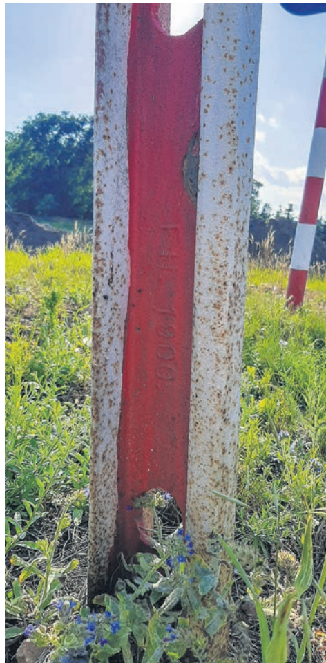
Sygnowane szyny na ul. Lotniczej.
