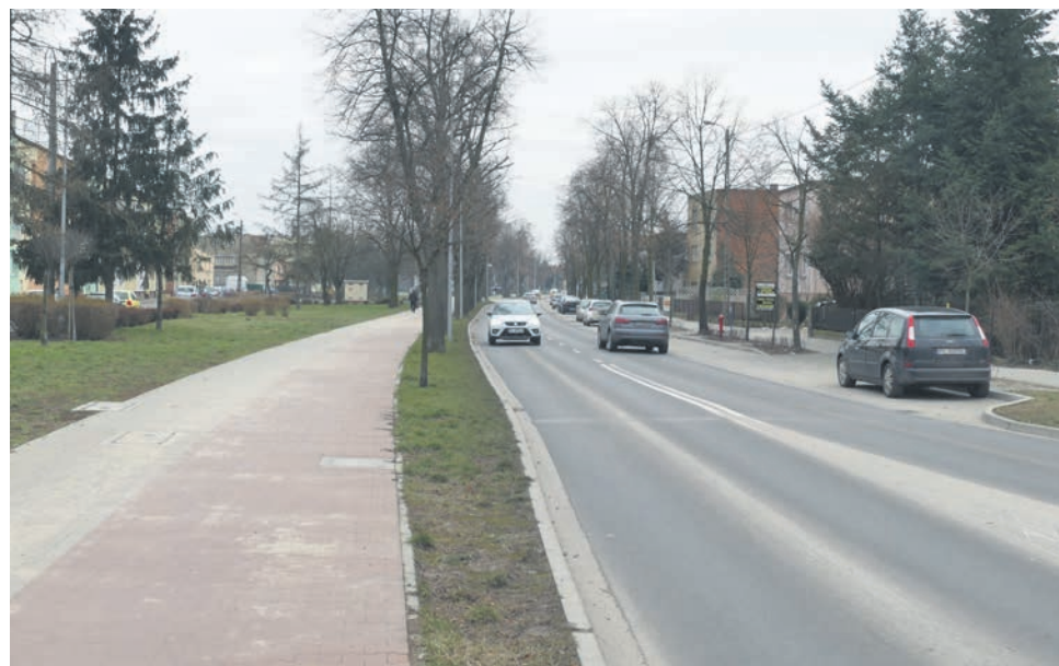
LUTY 2021. Ta sama ulica Lipowa prawie dwa lata później. O remoncie już zapomnieliśmy - dziś jeździmy gładką i wygodną drogą.
