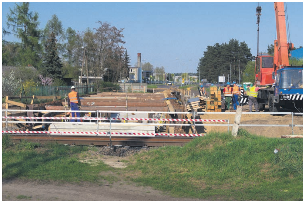
KWIECIEŃ 2018. Ulica Okrężna, Leszno. Ślimacząca się budowa przejścia podziemnego pod torami kolejowymi w ramach przebudowy linii kolejowej E59. Miejsce, w którym życie stracił niejedyn człowiek przechodzący "na dziko" przez torowisko.
