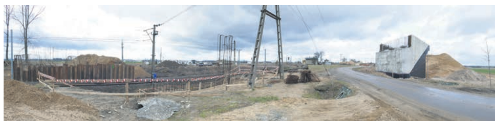
LUTY 2020. Droga między Bojanowem a Pakówką. Jeszcze wtedy funkcjonował w tym miejscu przejazd z rogatkami, a nowy wiadukt dopiero miał piąć się w górę. Na zdjęciu widać jeden z przyczółków.
