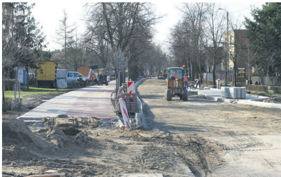
MARZEC 2019. Ulica Lipowa w Lesznie - główny trakt wyjazdowy w kierunku Góry. Tak wyglądała ulica w trakcie prowadzonej przebudowy.
