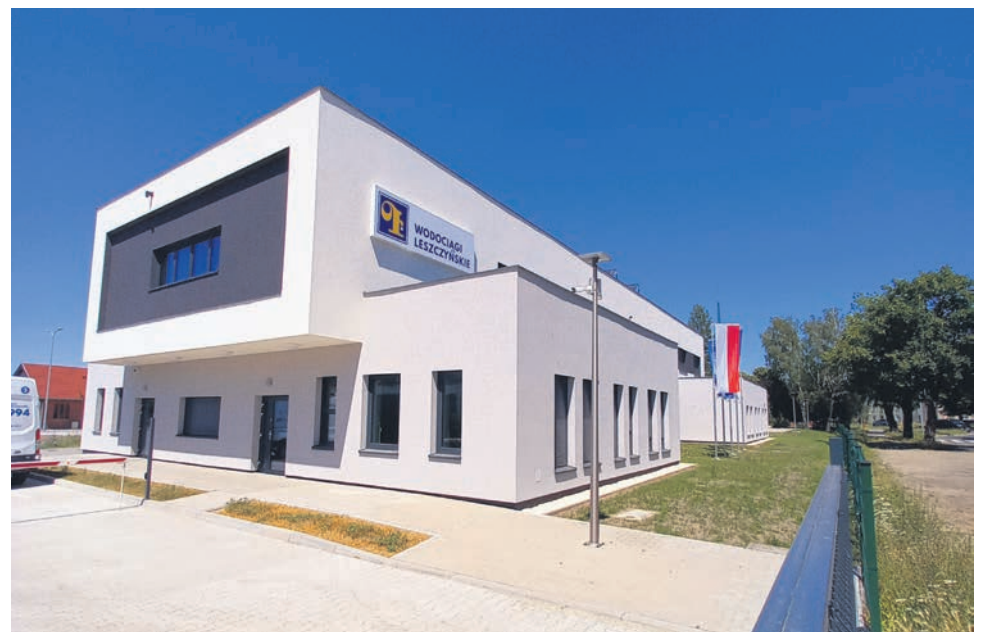
Energooszczędny budynek sanitarno-szatniowy z częścią biurową przy ul. Henrykowskiej w Lesznie, na terenie siedziby Wodociągów Leszczyńskich – 2022 rok
