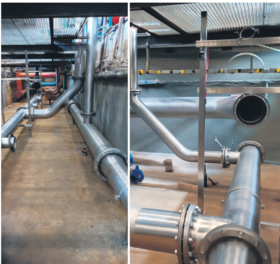
Nowy rurociąg technologiczny
