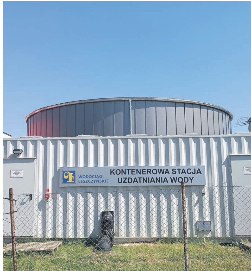
Kontenerowa Stacja Uzdatniania Wody w Lipnie
