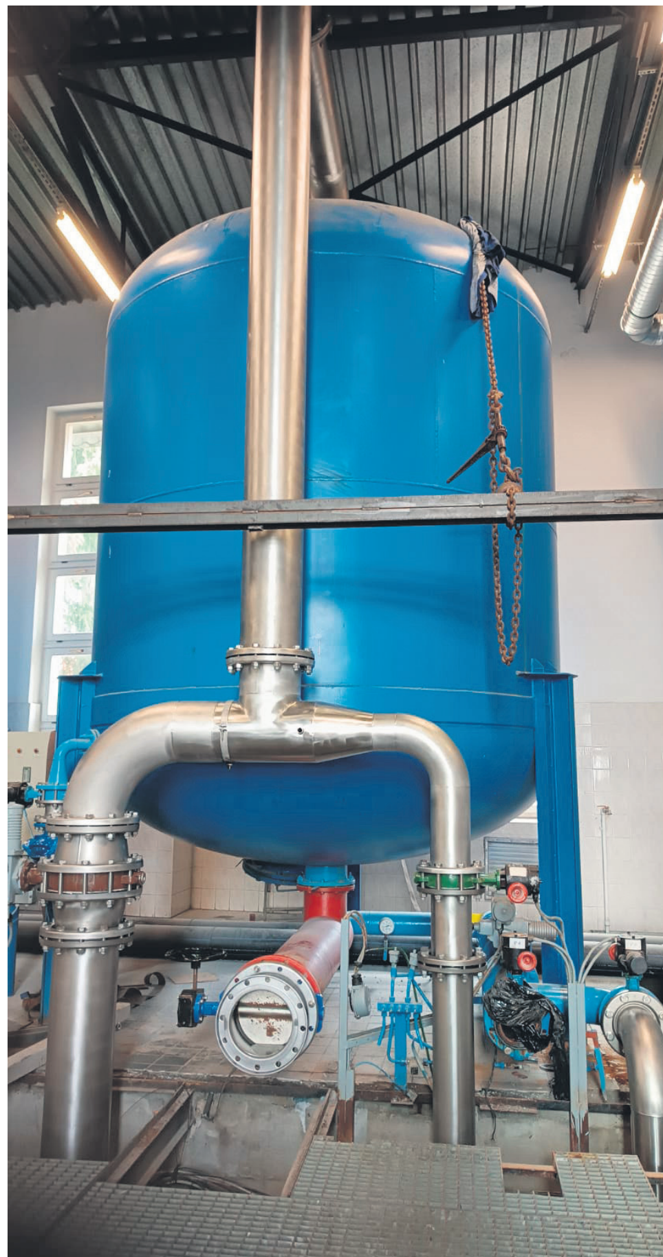
Wymiana orurowania przy filtrach ciśnieniowych
