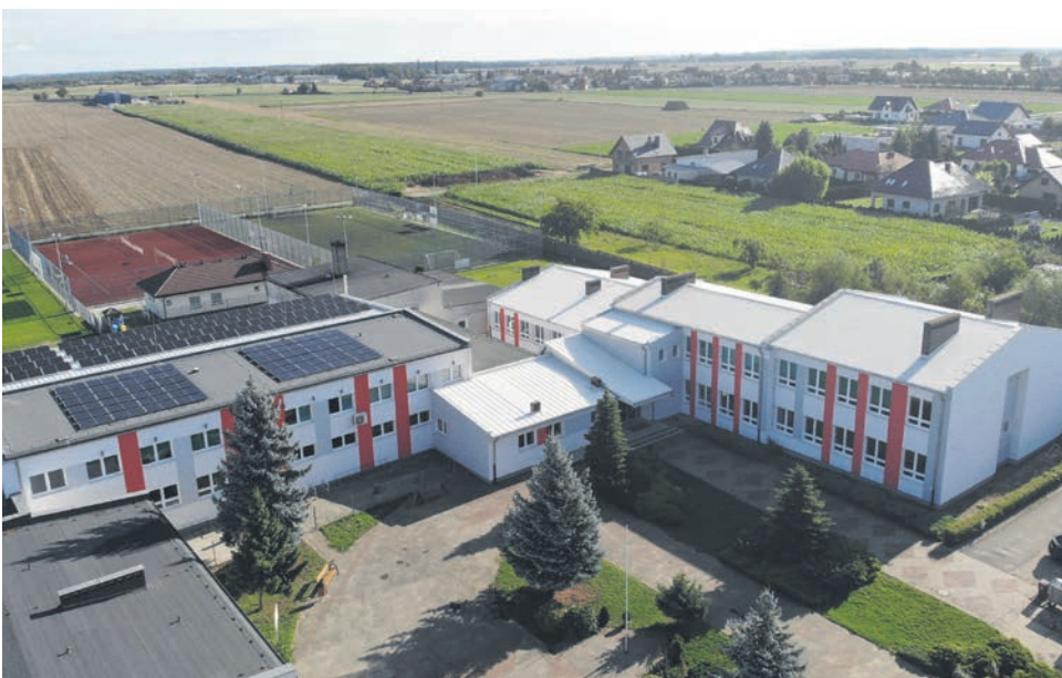
Termomodernizacja szkoły w Lipnie
