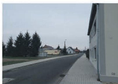
Przebudowa drogi Goniembice - Koronowo - Ratowice - Żakowo 9 643 165 zł (dofinansowanie 7 030 000 zł)
