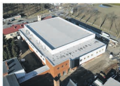
Hala sportowa w Wilkowicach w realizacji (dofinansowanie 5 471 900 zł)
