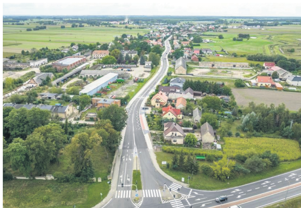
Przebudowa drogi w Kłodzie (2022 r.)
