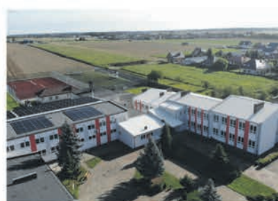
Termomodernizacja szkoły w Lipnie 3 095 834 zł (dofinansowanie 2 429 680 zł)
