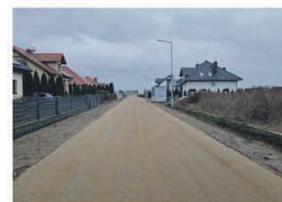
Przebudowa dróg w Lipnie i Mórkowie w realizacji (dofinansowanie 4 995 000)
