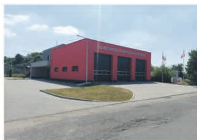
Remiza strażacka w Lipnie 1 857 708 zł
