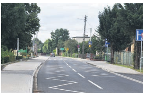
Przebudowa ul. Dworcowej w Krzemieniewie (2021 r.)
