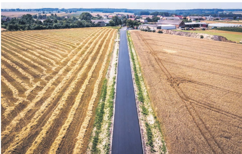
Przebudowa drogi Górką Duchowna - Targowisko (2021 r.)
