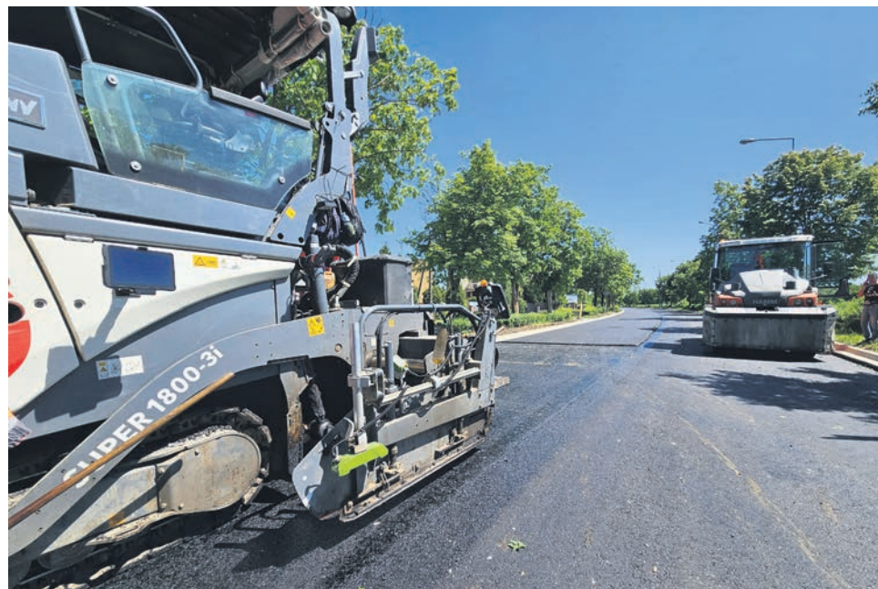
Podczas układania warstwy bitumicznej
