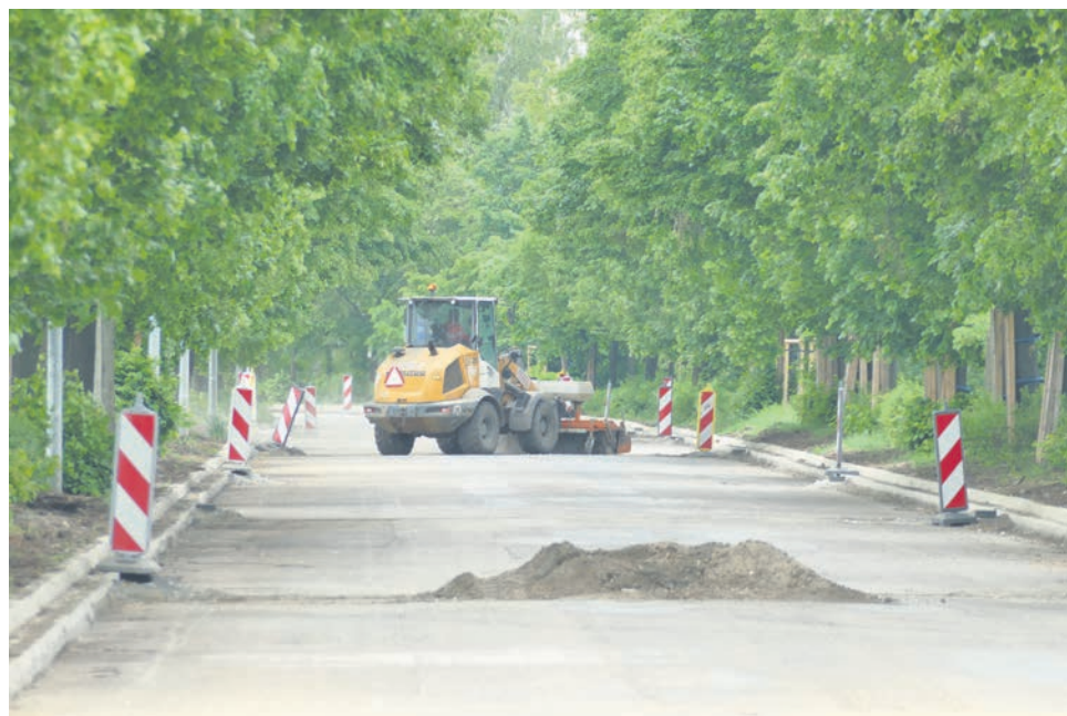
Ulica Wolińska po sfrezowaniu starej nawierzchni
