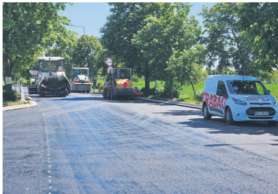
W trakcie prac wykonywanych przez firmę Strabag
