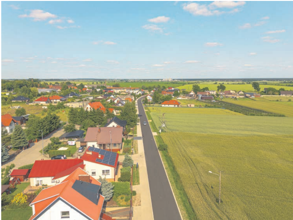
Przebudowana ulica Nowa w Długim Starym
